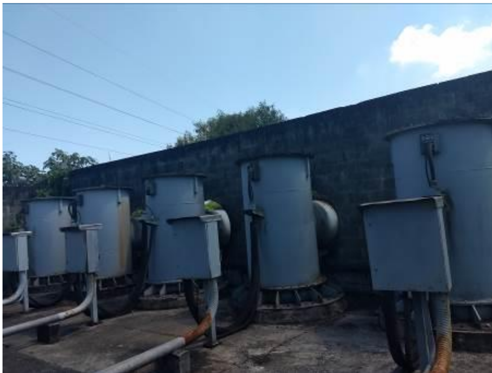
Figura 39 - Elemento de transição das bombas FLYGHT P 7101
